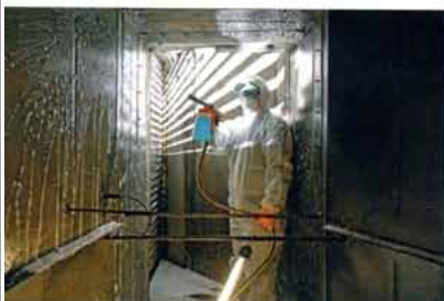
Aufbringen der Reinigungsflüssigkeit
