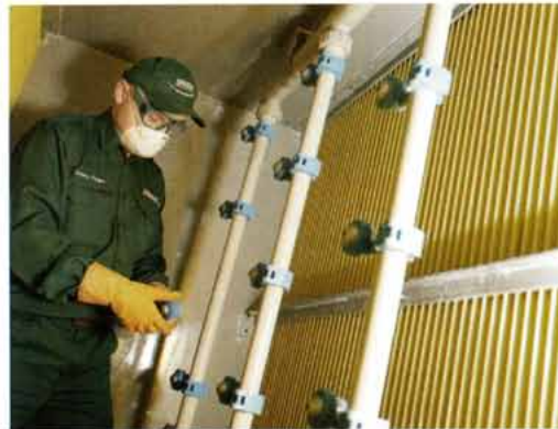
Montage der Sprühköpfe nach der Reinigung
