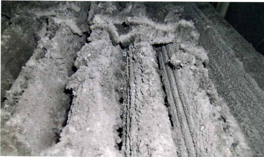
Stark verschmutztes Register
