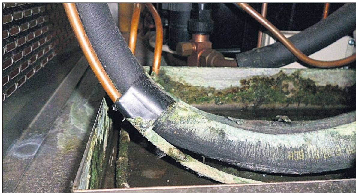
Wird die Verkleidung von Küchengeräten abgenommen, so kommen auch hier in den meisten Küchen starke Verschmutzungen zum Vorschein.
