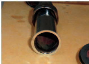
▲ Demontierter Waschbeckensiphon – links mit starken Schmutzablagerungen, rechts nach der Behandlung durch Gesec
