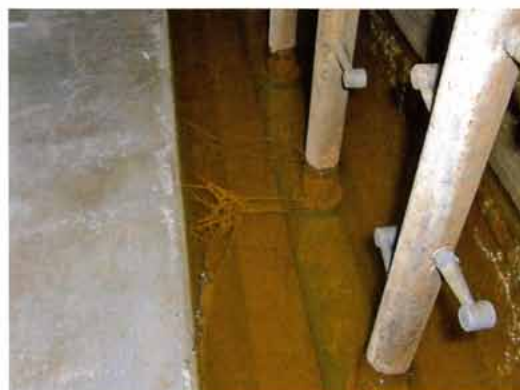
Wäscherkammer mit stark sichtbarem mikrobiologischen Befall. Bei der Untersuchung des Wassers wird nicht nur die Gesamtkeimzahl bestimmt, sondern auch das Vorkommen von Legionellen und ggf. Pseudomonaden sowie von Pilzen und Hefen.
