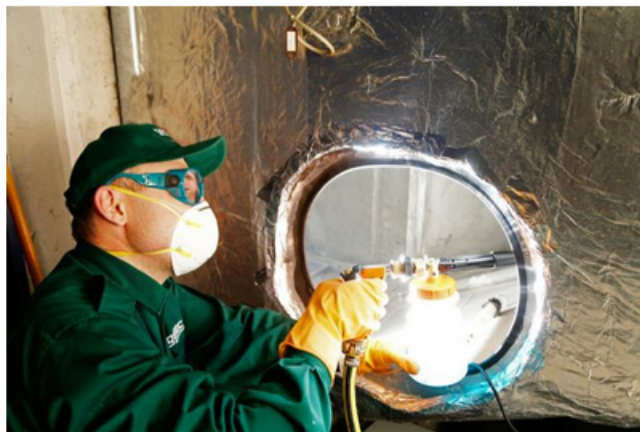
Reinigung eines Luftkanals © Gesa Hygiene-Gruppe
