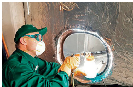
Reinigung eines Luftkanals
