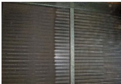
Heizregister links schmutzig, rechts gereinigt
