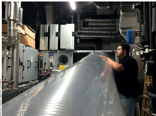
Dichtstoff wird zerstäubt und strömt in den Luftkanal
