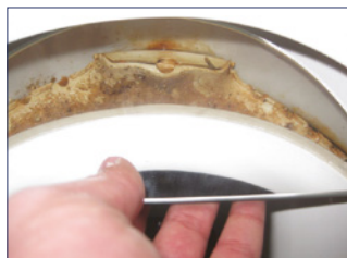
Dem Blick oft verborgen: unhygienische Ablagerungen am Spülrand einer Toilette. Quelle: Gesec
